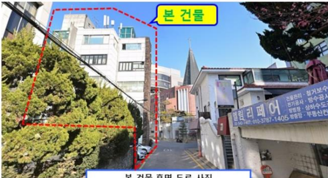
본 건물 후면 도로 사진
